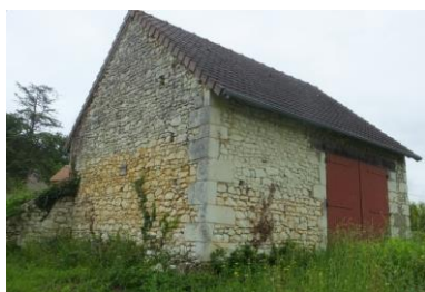
Bâti fréquenté par le Lézard des murailles, sur site
