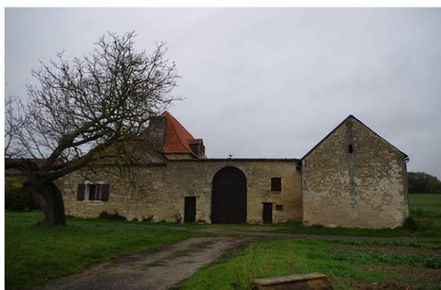
La Bordillière. Ferme patrimoniale avec maison bourgeoise, porche d'entrée, un pigeonnier (voir ci-dessous) entretenant une relation forte avec le val d'Ozon. Parcelles 63, 315, 316, 55, 272.
