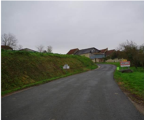
1 - Entrée Ouest par la D38 : L'entrée en section montante due à la vallée humide du Moury permet de bien faire ralentir les véhicules à l'approche de l'école.
