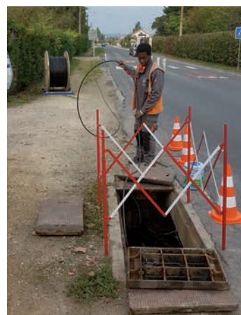
Pose de fibre optique
